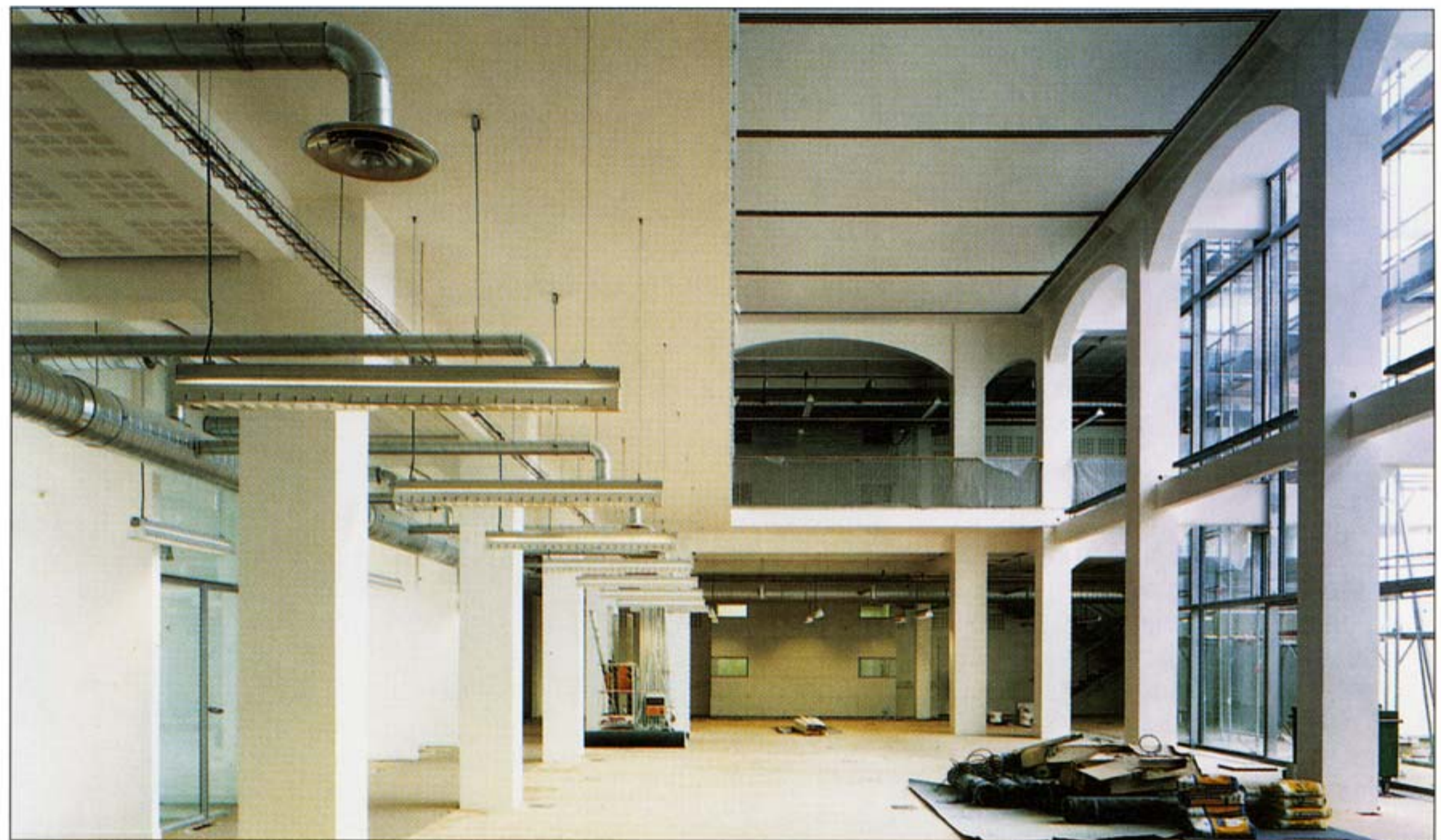
Le futur immeuble d'Euro RSCG BETC, toujours en travaux, offrira des espaces publics et privés décloisonnés
