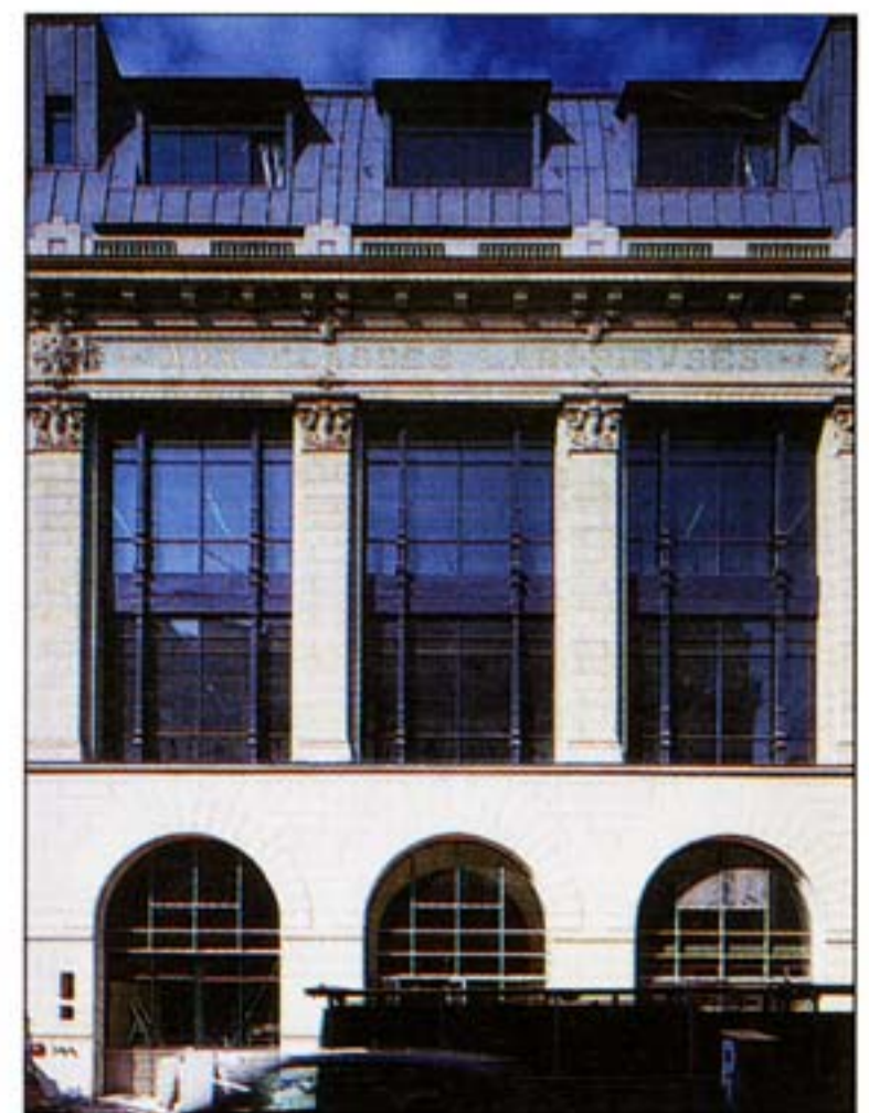
Une construction en phase avec « la philosophie de l'agence »
