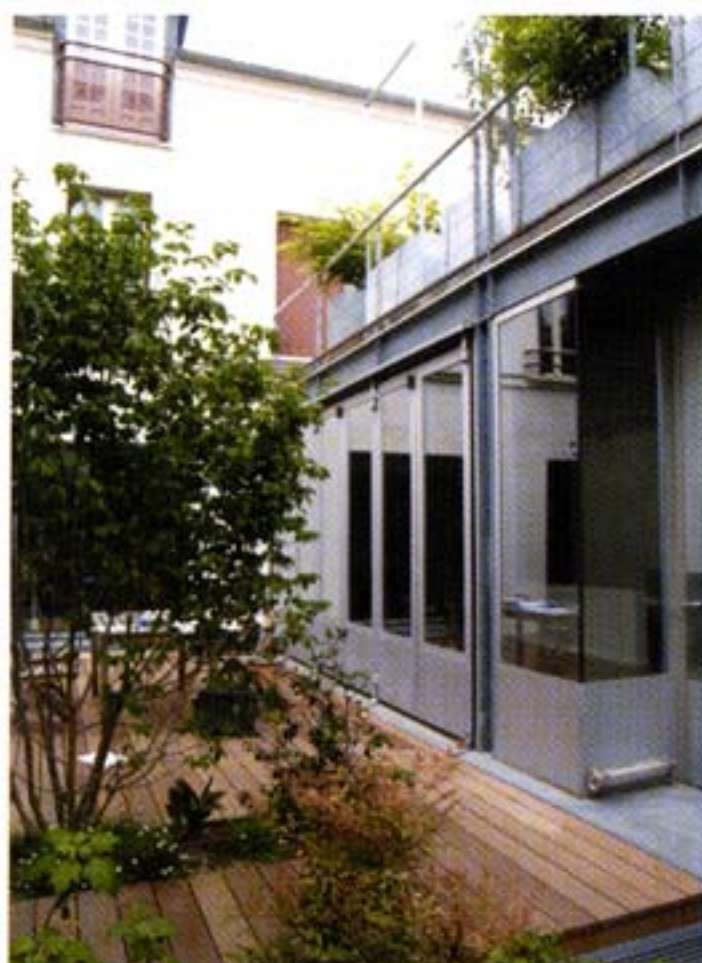
Vue de la façade sur jardin.
