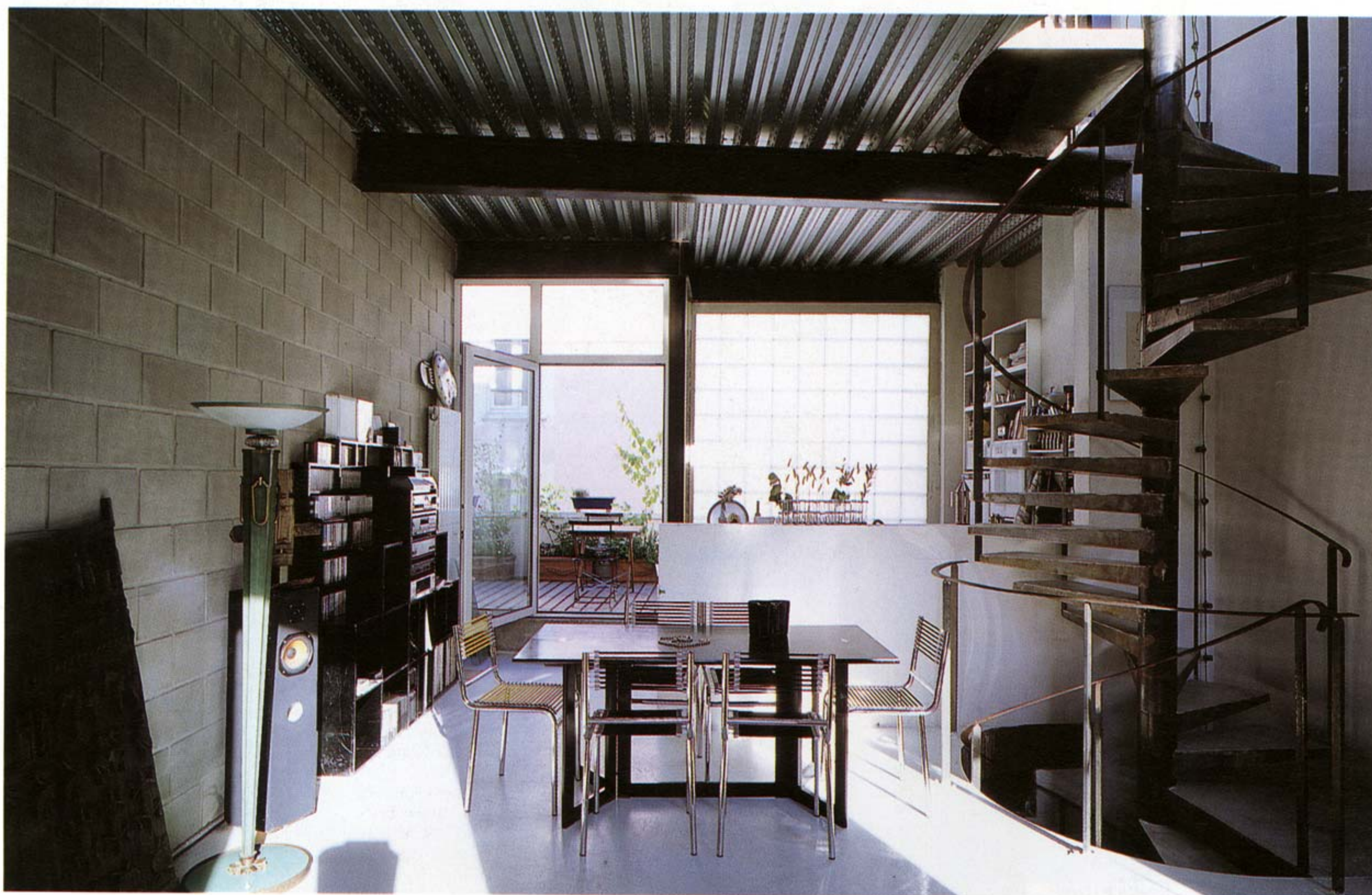
Extension à la verticale d'un petit immeuble industriel et division toute hauteur par un mur en parpaing Besser. || Vertical extension, and vertical division by a concrete block wall, of a small, industrial building.
